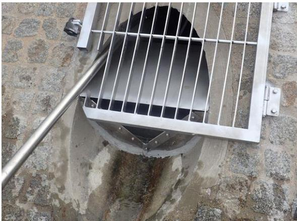
Messblende DN600 mit Drucksonderohr
