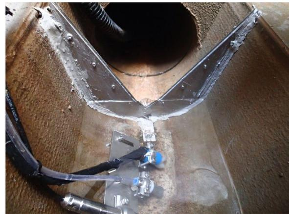
Minimessblende mit Drucksonde, Filterkorb
